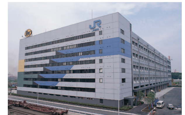
新東京主管支店が入居したエフプラザ東京
